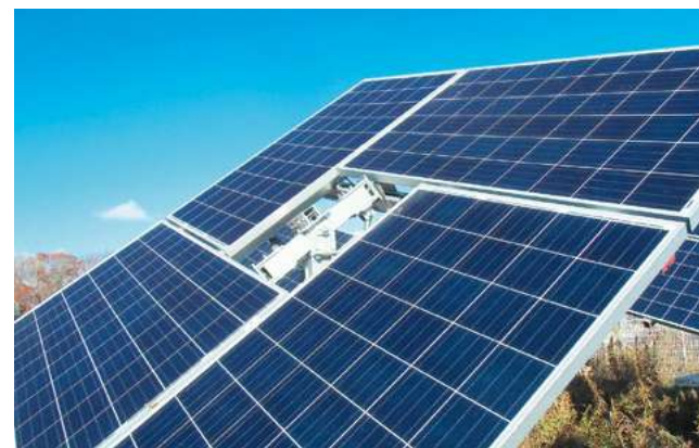
ジャイロ型太陽追尾架台に設置された太陽光パネル
